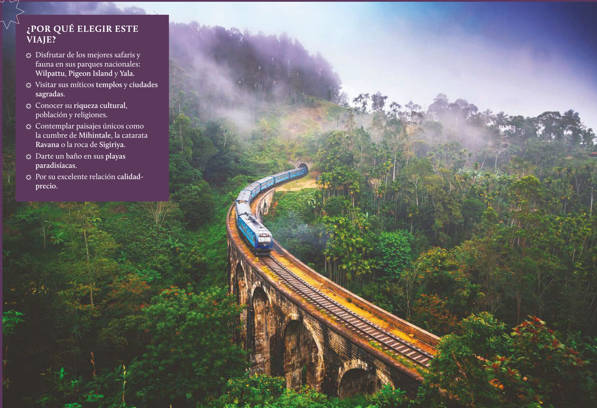
♥ Tren de Ella sobre el puente de los nueve arcos.
